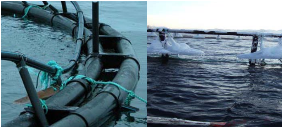
Figur 2. Knekt gelender som følge av at hoppenett har hengt på stålkroker under en periode med høy ising (Foto: Barlindhaug Norfico AS) og eksempel på hvordan is bygger seg opp på løst tauverk (Foto: Sponfish AS).
