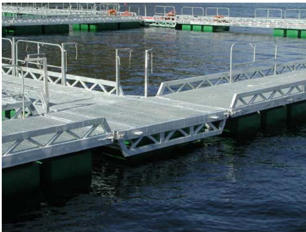
Figur B.1. NM 5000 anlegg med fagverkforsterkning.
