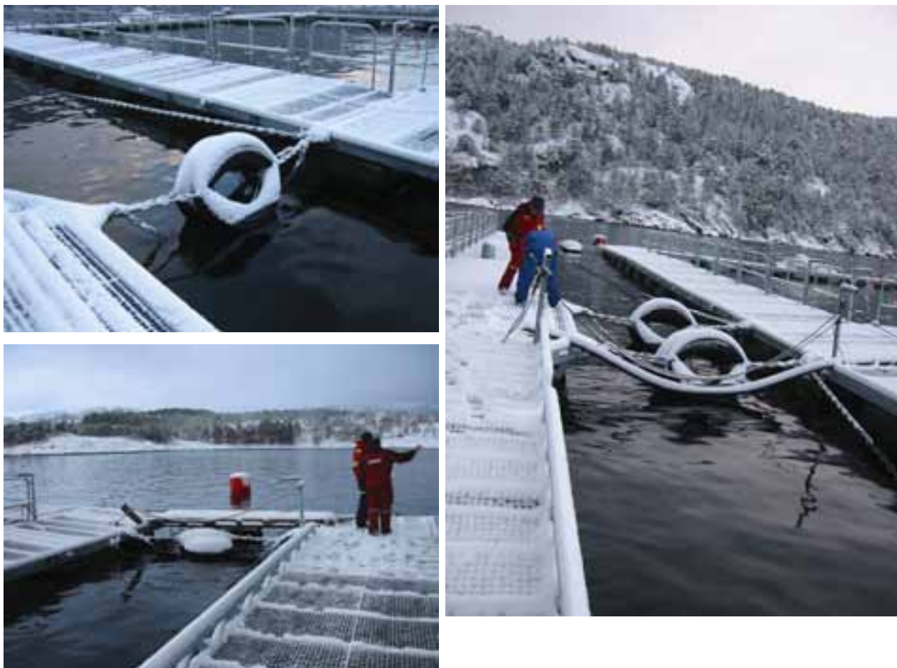
Figur B.4. Bilder av fortøyning mellom NM5000 og miljøanlegget.
